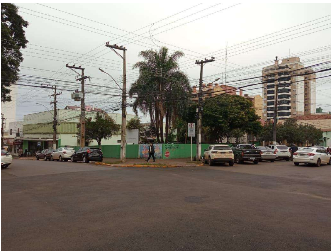
Figura 6 - Vista frontal - Esquina das Ruas Ernesto Alves e José Bonifácio
