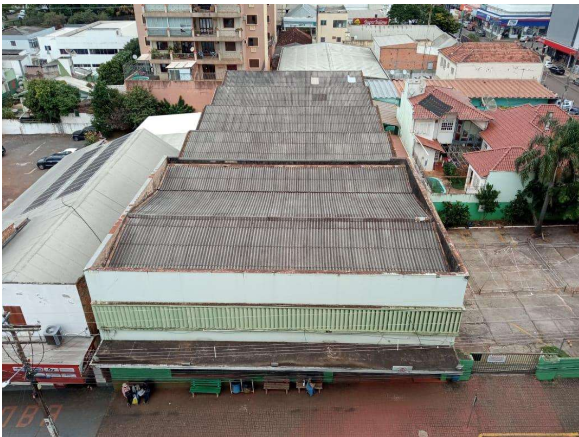
Figura 5 - Vista frontal superior - Rua Ernesto Alves
