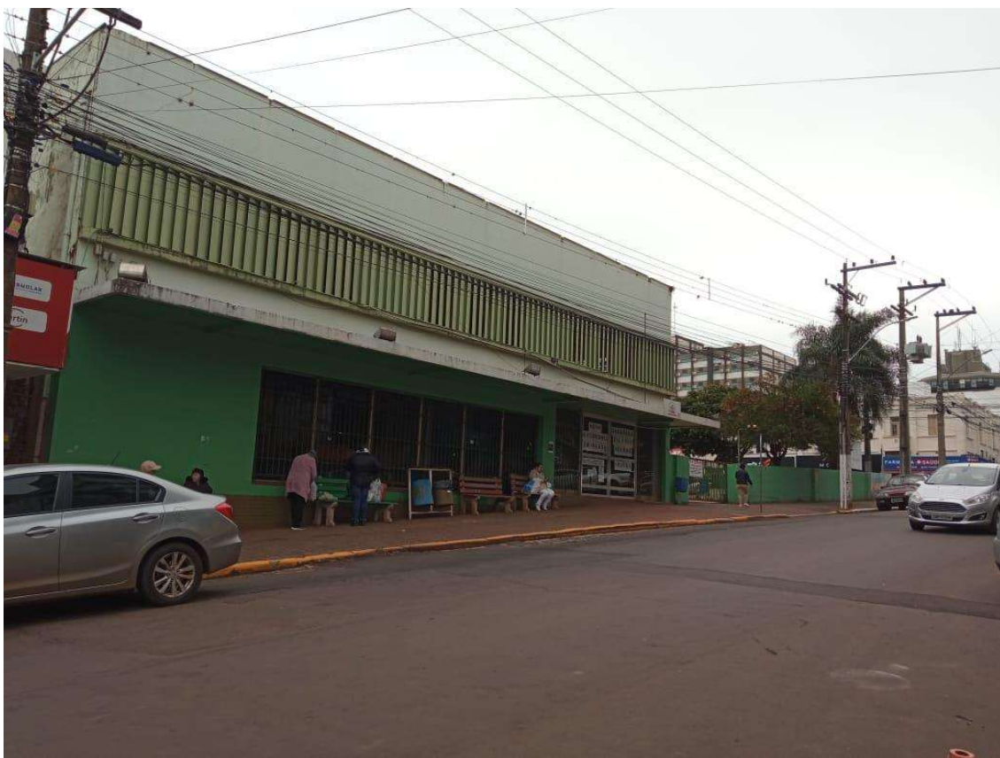
Figura 4 - Vista frontal - Rua Ernesto Alves
