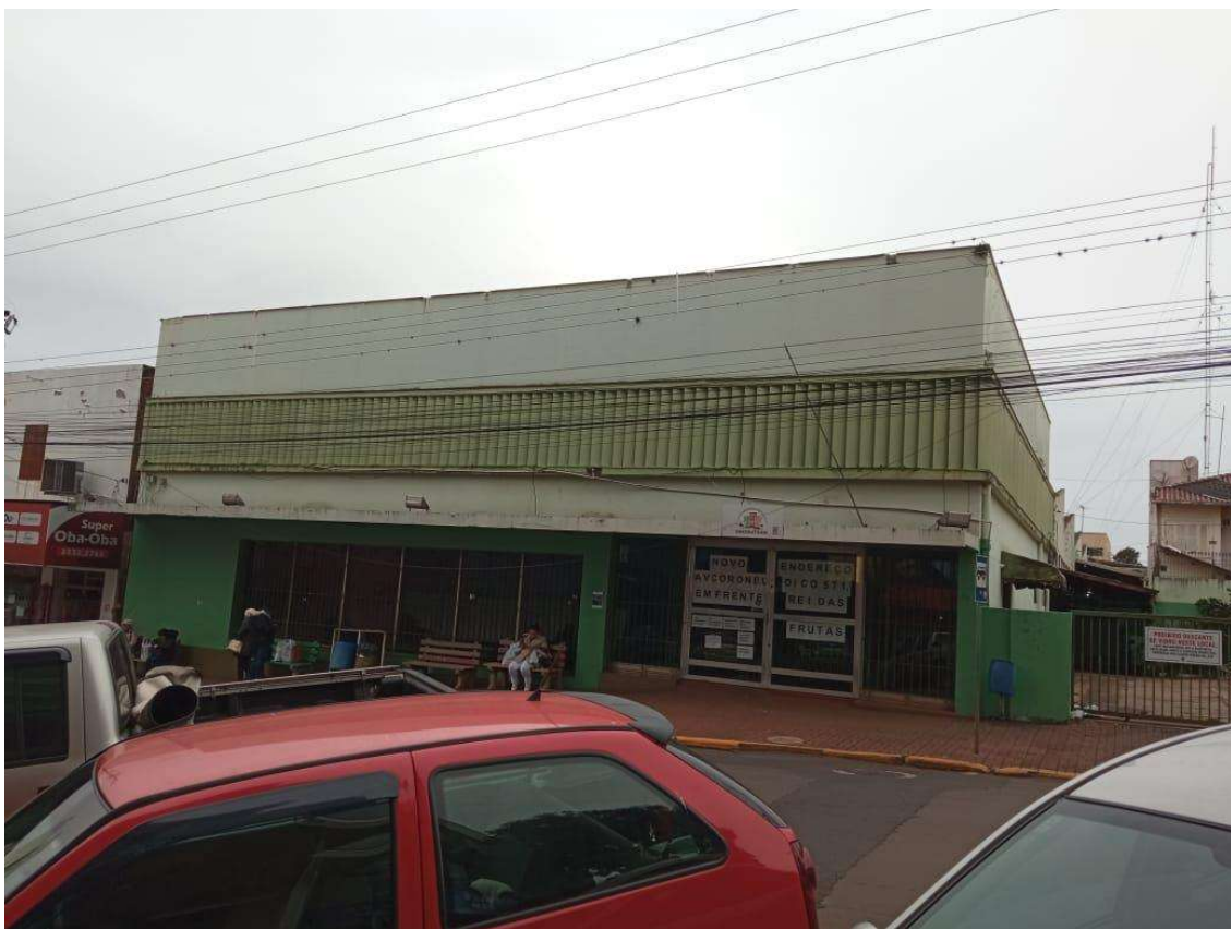
Figura 3 - Vista frontal - Rua Ernesto Alves
