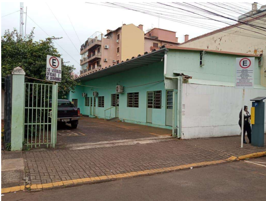
Figura 8 - Vista frontal - Rua José Bonifácio
